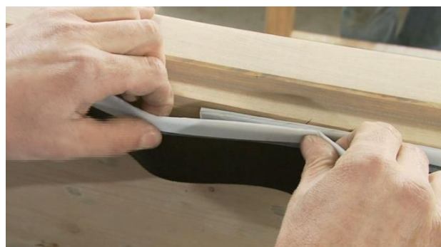
napojenie pásky pri ukončení
