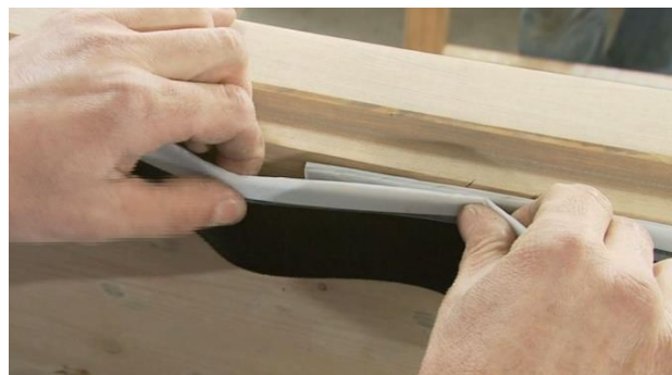
napojení pásky při ukončení
